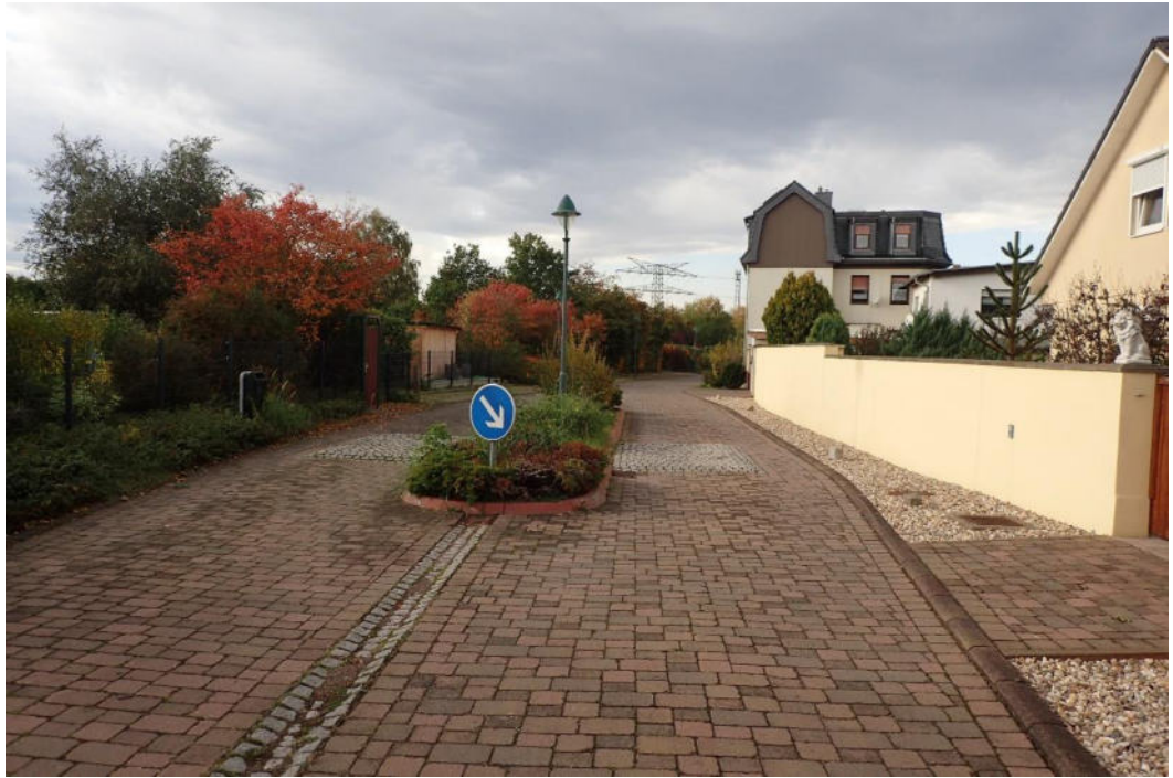
Abb. 16: Teilplateauaufpflasterung in der Dorfstraße Schkopau OT Korbetha (Quelle: ISUP)
