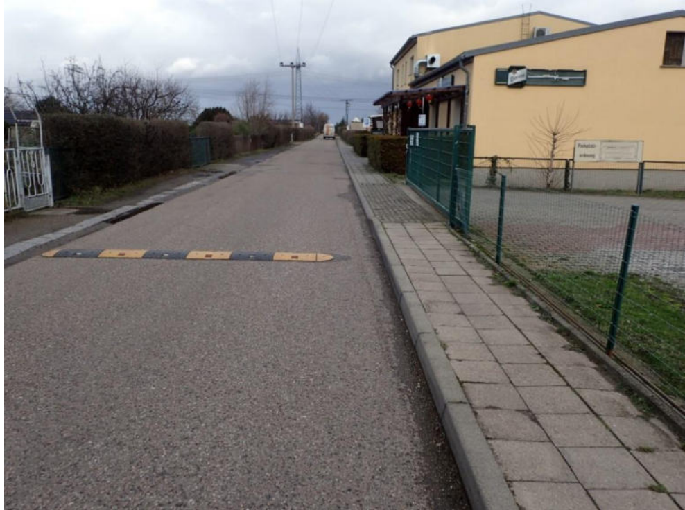
Abb. 14: Bodenschwelle Salzhole (Quelle: ISUP)
