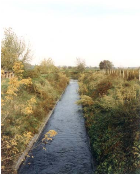
Abb. 27: Der Renaturierungsbedarf am Kliialauf ist deutlich zu erkennen
